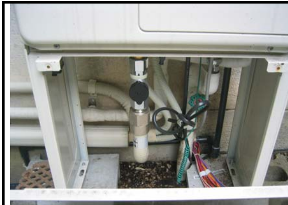
ドレン配管を中心とした写真
