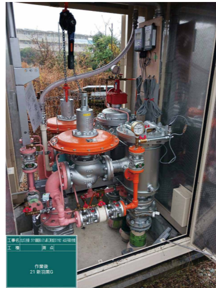
▲新羽黒ガバナ-自記圧力計DA307N取付け(右上)
